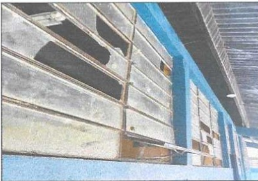
Foto 3: Sustitución de vidrios y colocación de balcones en los ventanales.
