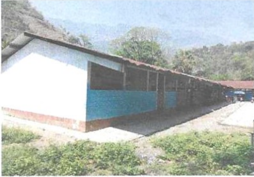
Foto1: Sustitución de láminas del módulo ya que se encuentran muy deterioradas.
