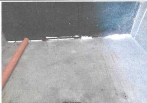
Foto 5: Sustitución de puertas de metal que se encuentran deterioradas.
