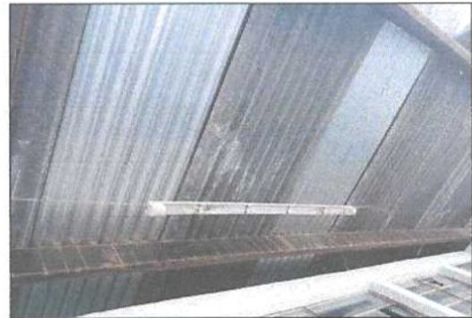
Foto 4: Sustitución y reparación del sistema eléctrico en general e instalación de nuevos accesorios.
